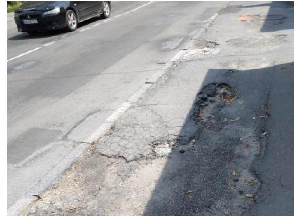
нерівності покриття >2 см (21%)
